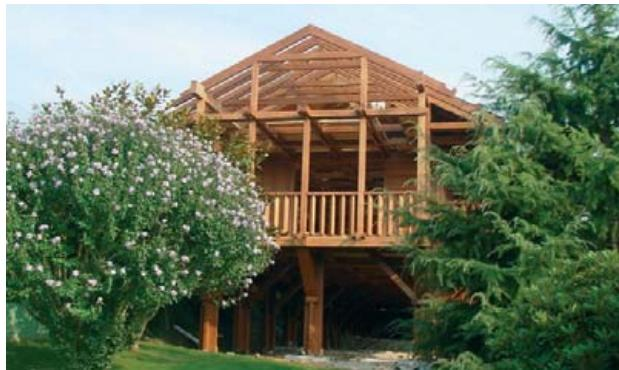
Con esta construcción búscase fomentar a utilización de elementos e soluciones técnicas realizadas coa materia prima procedente dos nosos montes. Polo tanto, será unha vivenda básicamente construída en eucalipto, pino e castaño.
